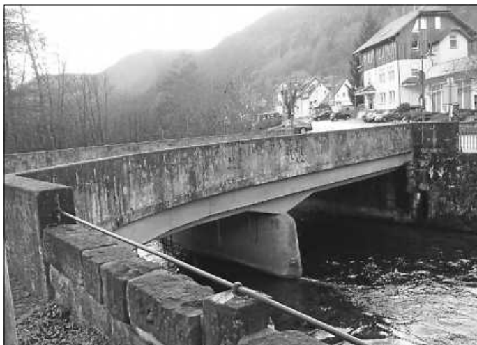
Mit Kosten von knapp 240.000 Euro lässt die Gemeinde Höfen in diesem Jahr die Ochsenbrücke sanieren. Foto: Ziegelbauer
