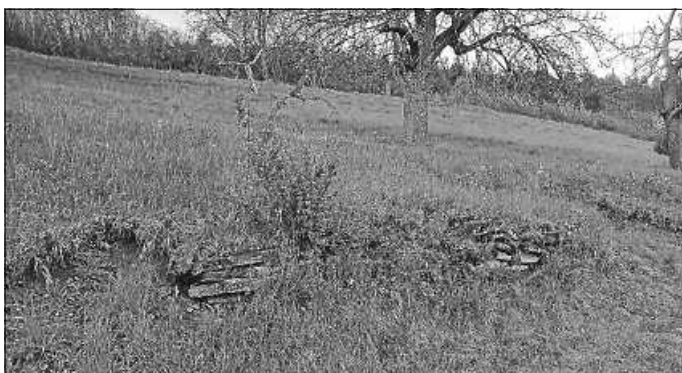
Trockenmauer vor der Sanierung in Wildberg. Foto: Landschaftserhaltungsverband Landkreis Calw e. V.
