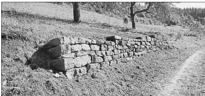
Trockenmauer nach der Sanierung in Wildberg. Foto: Landschaftserhaltungsverband Landkreis Calw e. V.
